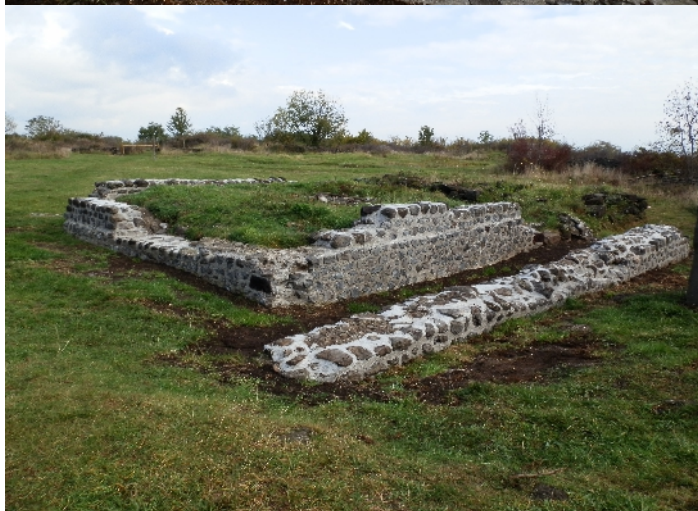
Fanum vu du côté sud : au premier plan, mur de la galerie ; au second plan, les trois murs de la cella Photographies ASCOT, 2014
